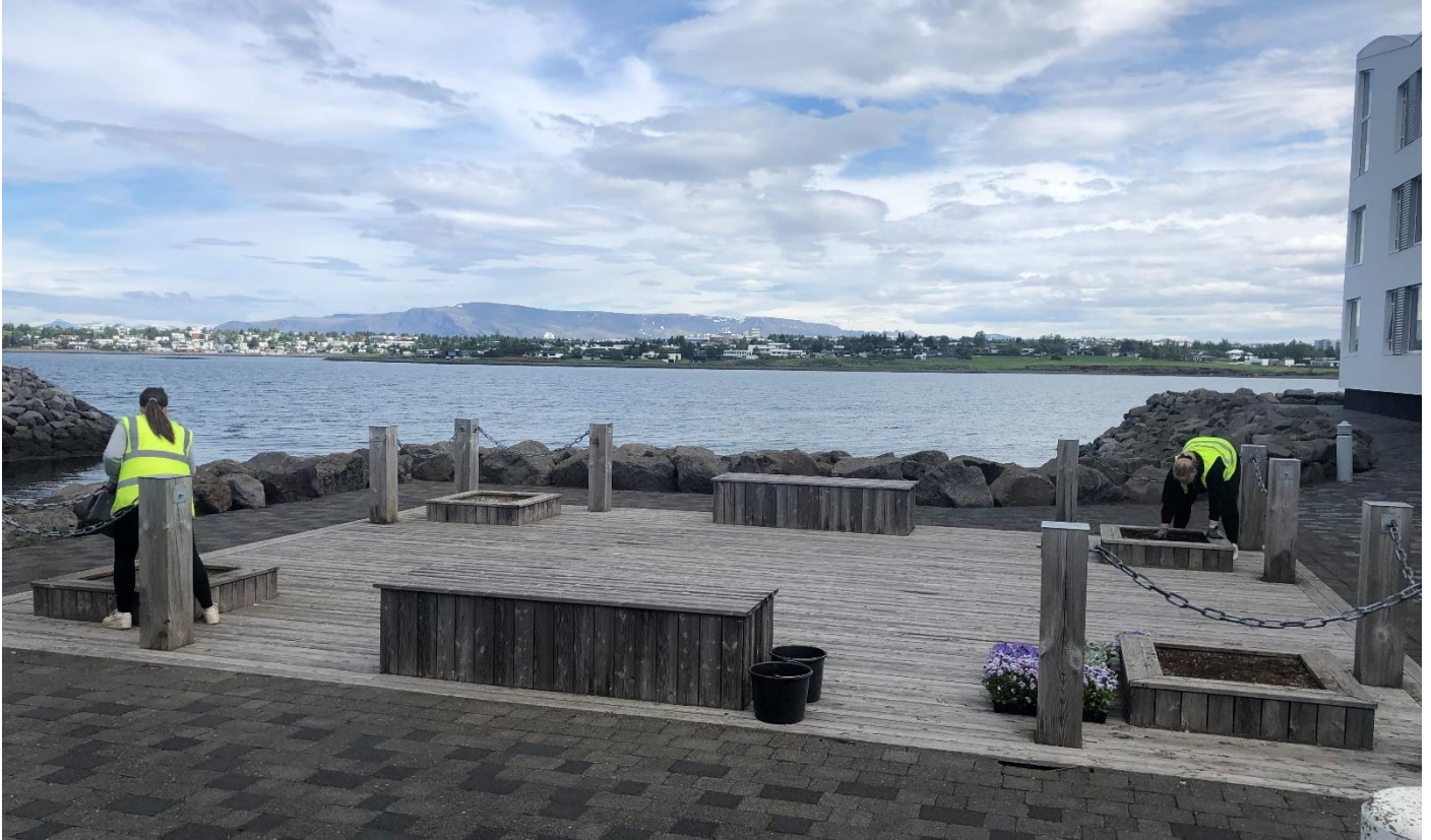
Mynd: Verið að undirbúa gróðurkassana fyrir sumarblóm með því að hreinsa þá og setja áburð
