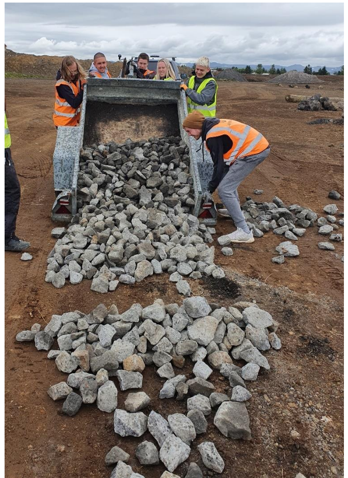
Mynd: Verið að losa grjótið á jarðvegstippinum
